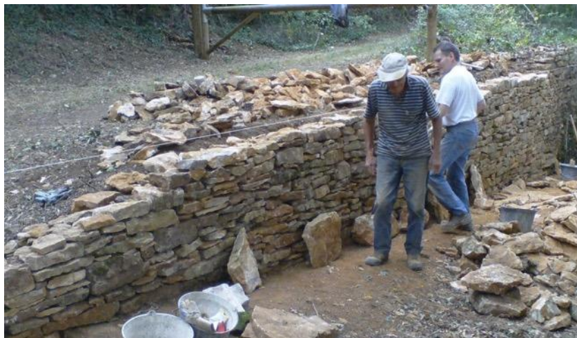
Montage d'un mur en pierres sèches
