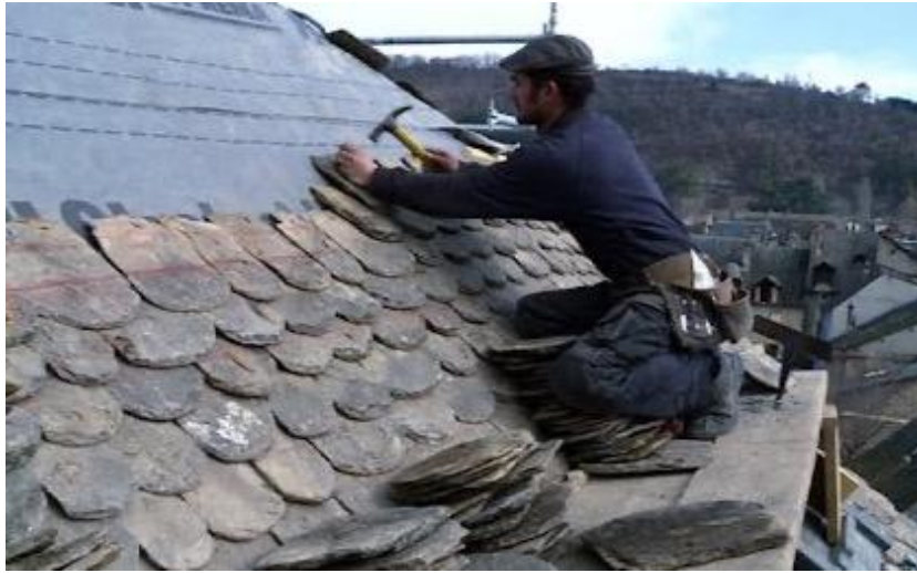
Métier de couvreur - toit en lauzes de schiste
