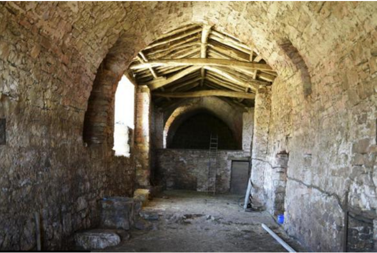
Ferme des Crottes : la maison et en retour la grange
