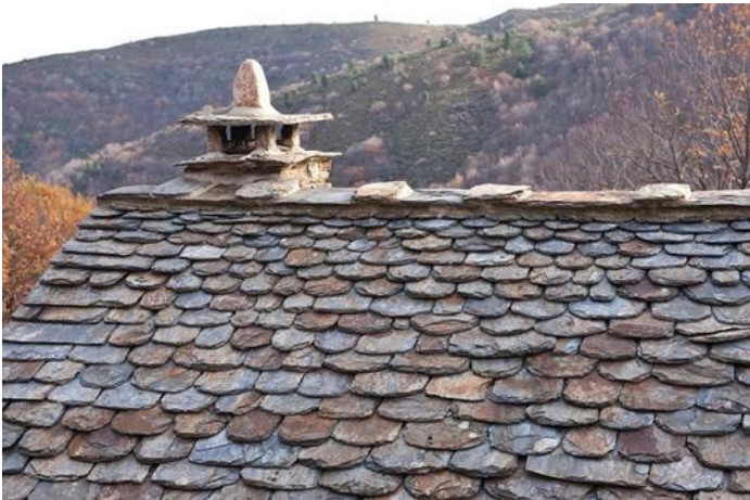
Toiture en lauzes de schistes
