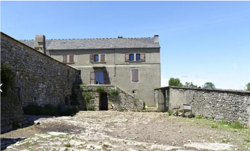
Ferme des Crottes : la bergerie, partie voutée
