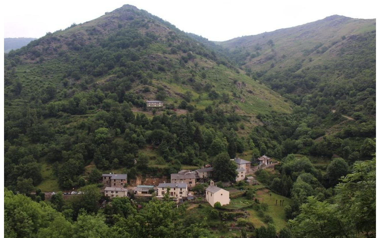
Vue depuis le sud-est du village de Bassurels. Hormis la disparition d'un bâtiment au niveau de la deuxième rangée de maisons, on n'aperçoit pas de maisons en ruines. Cependant, seulement deux d'entre elles (4 appartements) sont occupées à l'année
