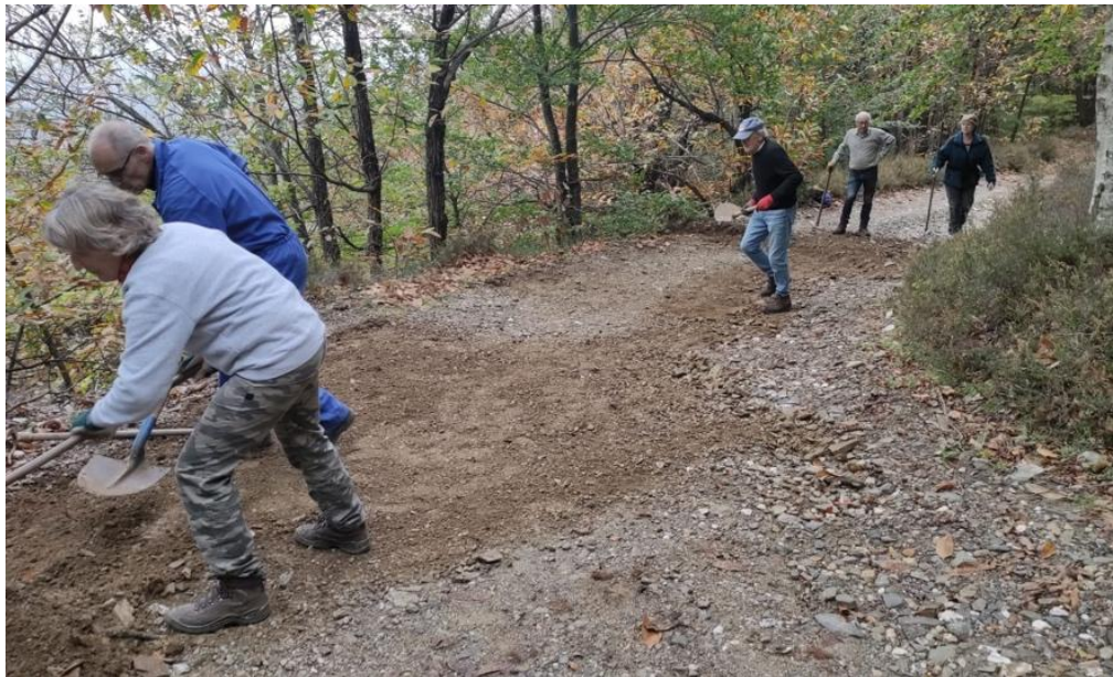
Robert et Anne récupèrent de la matière pour consolider le coupadou situé sous le dernier virage du haut du chemin
