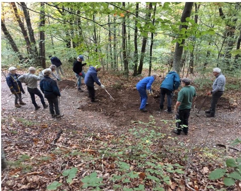
Réalisation du dernier coupadou avant l'arrivée du chemin sur la route départementale Qui a pu se détourner un instant de son labeur pour photographier ces deux champignons ??
