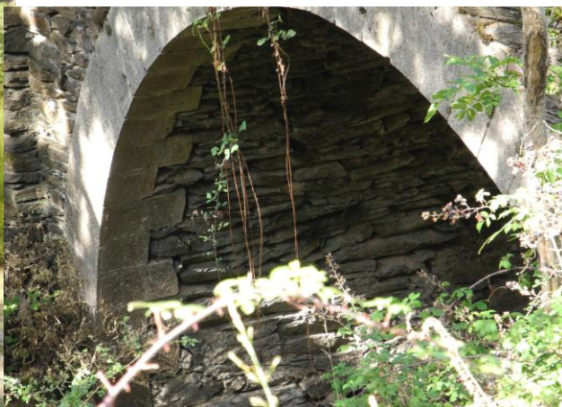
Coté aval de la voûte du nouveau pont montrant les pierres calcaires taillées habillant la voûte
